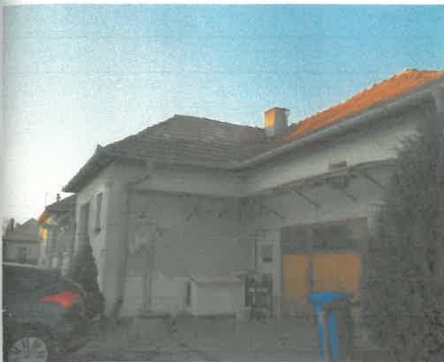
Rodinný dom s.č.6, na p.č.10, Lenartovce č.6 - pohľad JV z dvora
