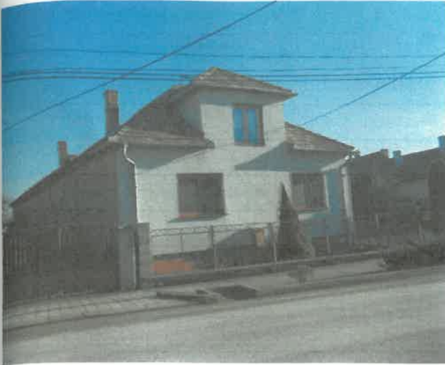
Rodinný dom s.č.6, na p.č.10, Lenartovce č.6 - pohľad S z cesty
