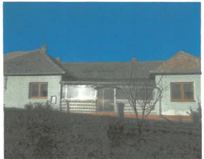
Rodinný dom s.č.6, na p.č.10, Lenartovce č.6 - pohľad JZ z dvora
